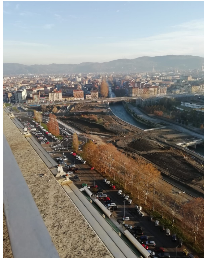
Parco Dora: cantiere (foto P. Odone)
